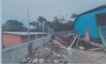
No. 1 MEJORAMIENTO DE MURO DE CONTECIÓN CON TRES HILERAS DE BLOCK, MALLA Y TUBO GALVANIZADO
