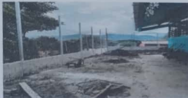
No. 3 MEJORAMIENTO CON MALLA EN EL LADO PONIENTE Y TRES HILERAS DE BLOCK
